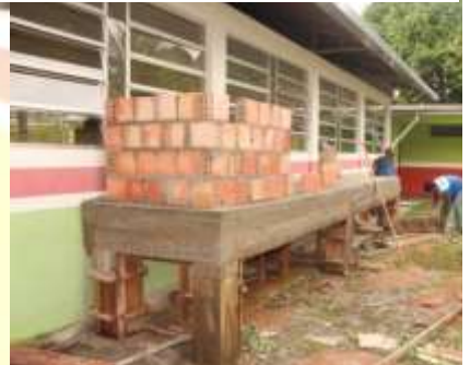
Figura 6 - Retirada dos moldes de madeira e construção da caixa de filtragem
