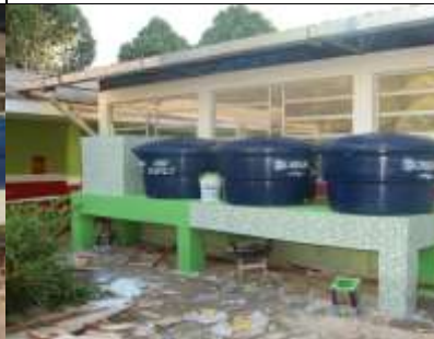
Figura 11 - Montagem das caixas de polietileno
