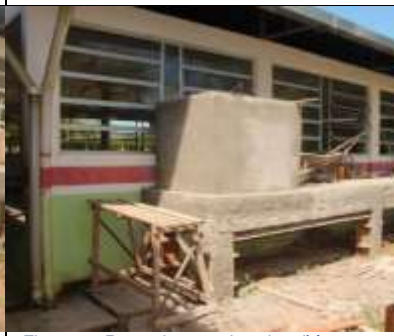
Figura 8 - Revestimento da caixa d'água com argamassa e impermeabilizante
