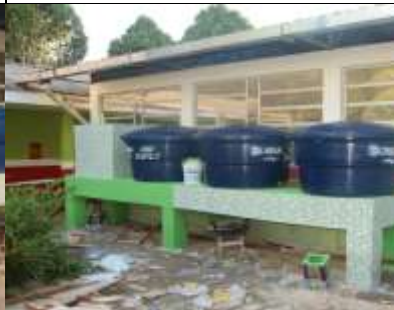
Figura 11 - Montagem das caixas de polietileno
