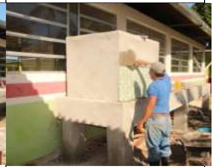
Figura 9 - Revestimento cerâmico com argamassa
