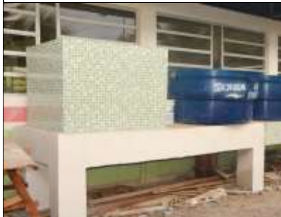
Figura 10 - Aplicação de rejunte e massa corrida
