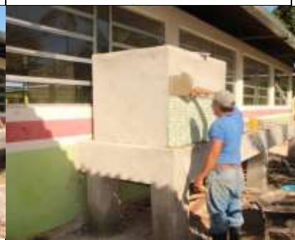
Figura 9 - Revestimento cerâmico com argamassa
