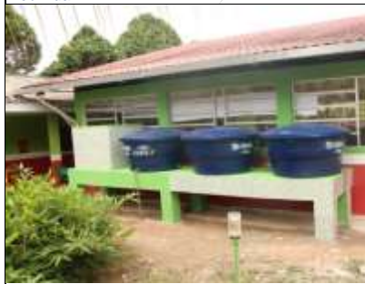
Figura 47 - Sistema de redistribuição da água pluvial armazenada
