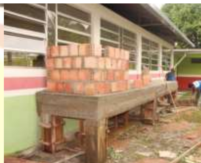
Figura 6 - Retirada dos moldes de madeira e construção da caixa de filtragem
