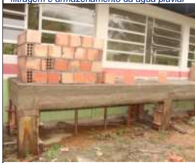
Figura 7 - Definição da caixa de filtragem com os compartimentos de seixo, areia e carvão
