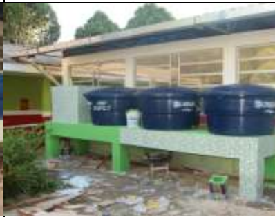
Figura 11 - Montagem das caixas de polietileno
