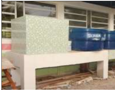
Figura 10 - Aplicação de rejunte e massa corrida
