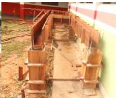
Figura 5 - Armação das ferragens e concretagem da base de sustentação
