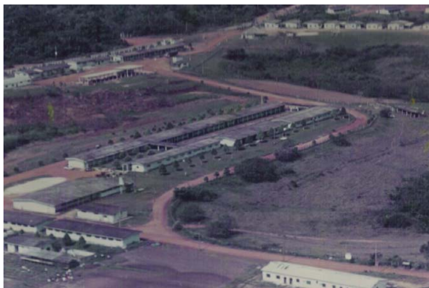
Figura 4: Vista aérea da Escola Agrotécnica Federal de São Gabriel da Cachoeira. Fonte: acervo do Campus São Gabriel da Cachoeira.
