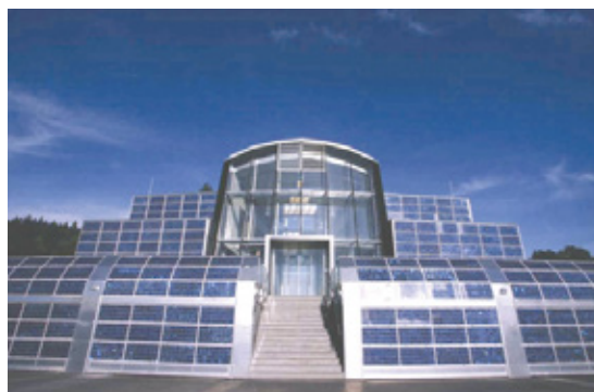
Figura 6 - Painéis fotovoltaicos aliados à arquitetura no Instituto de Propaganda, Upper Austria, KW-Solartech-nik, Áustria.
