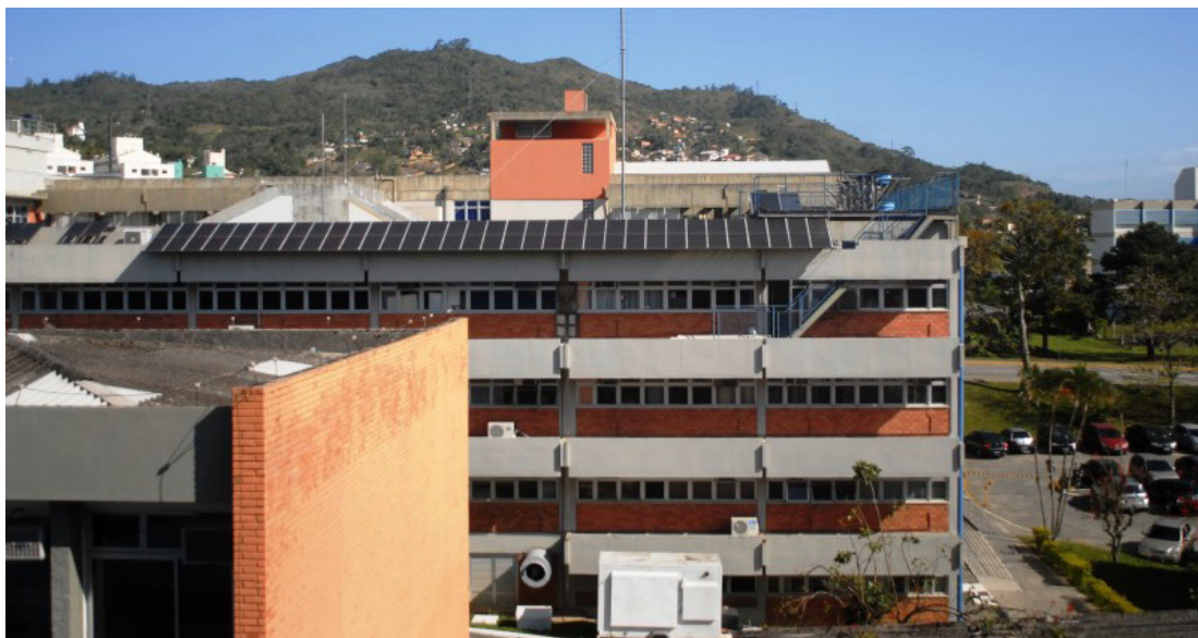
Figura 4 - Primeiro sistema fotovoltaico conectado à rede do Brasil usando tecnologia de silício amorfo, instalado na UFSC, - Florianópolis, SC
