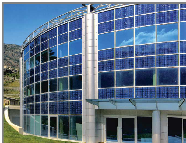
IMAGEM 5 E 6 SISTEMAS DE CAPTAÇÃO DE ENERGIA SOLAR 12
