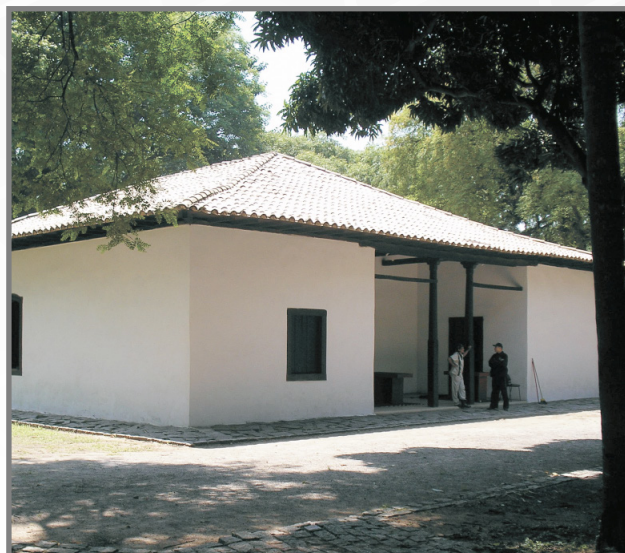
IMAGEM 2 - CASA DO BANDEIRANTE, BUTANTÃ, SÃO PAULO, CONSTRUÍDA NO SÉCULO XVII COM PAREDES DE TAIPA DE PILÃO 9
