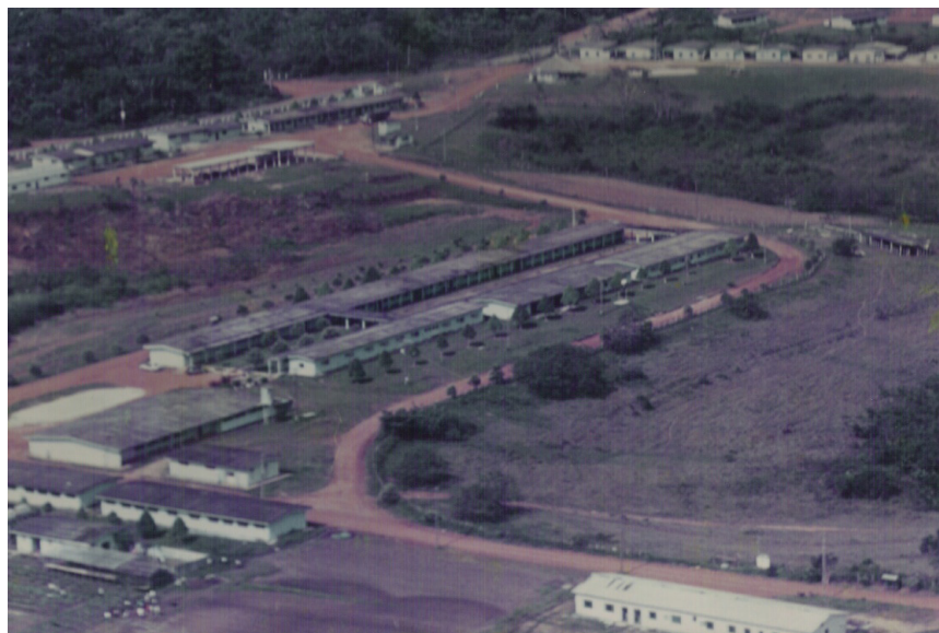
Figura 4: Vista aérea da Escola Agrotécnica Federal de São Gabriel da Cachoeira.
