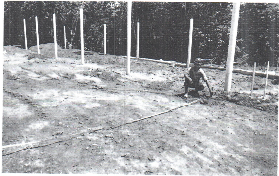
Fotografia 2 – Marcação das Vias e calçamento.
