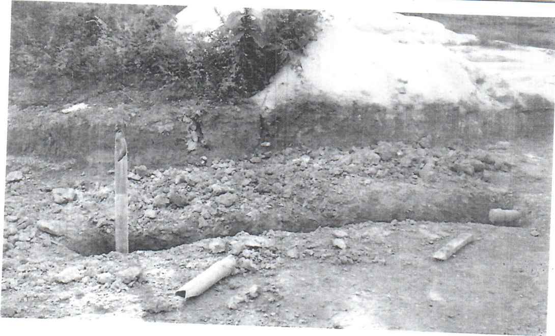
Fotografia 13- Tubulação danificada
