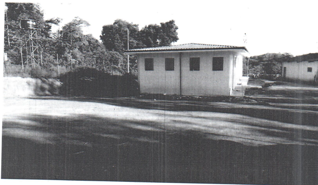
Fotografia 1 – Vista da fachada norte
