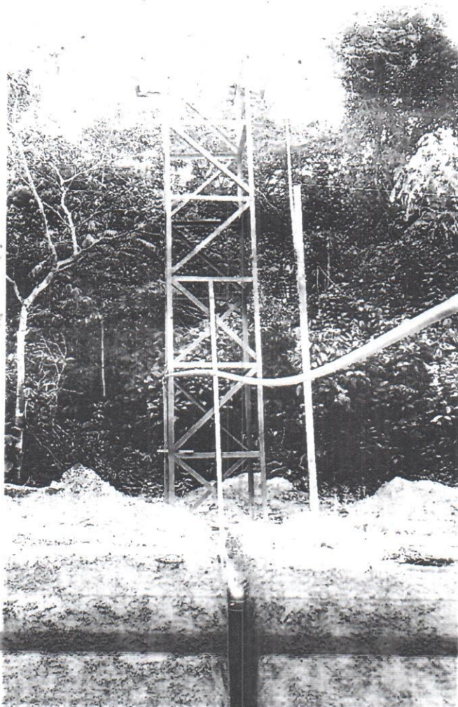
Fotografia 14 – Vista da Estrutura Metálica da Caixa D'água.
