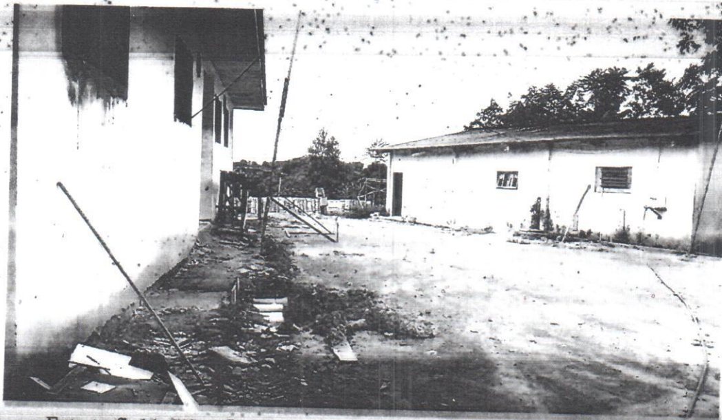
Fotografia 11 - Vista da elevação Posterior ( Colocação dos Exaustores).
