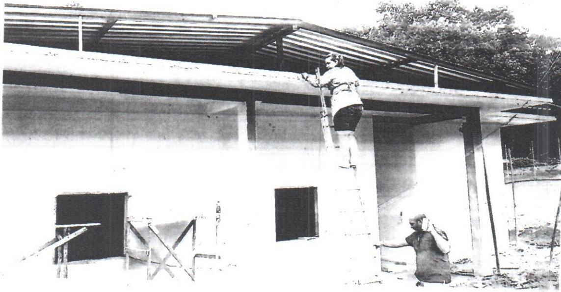
Fotografia 1 – Vista da estrutura Metálica da Cobertura (Supressão de Tesoura Metálica).
