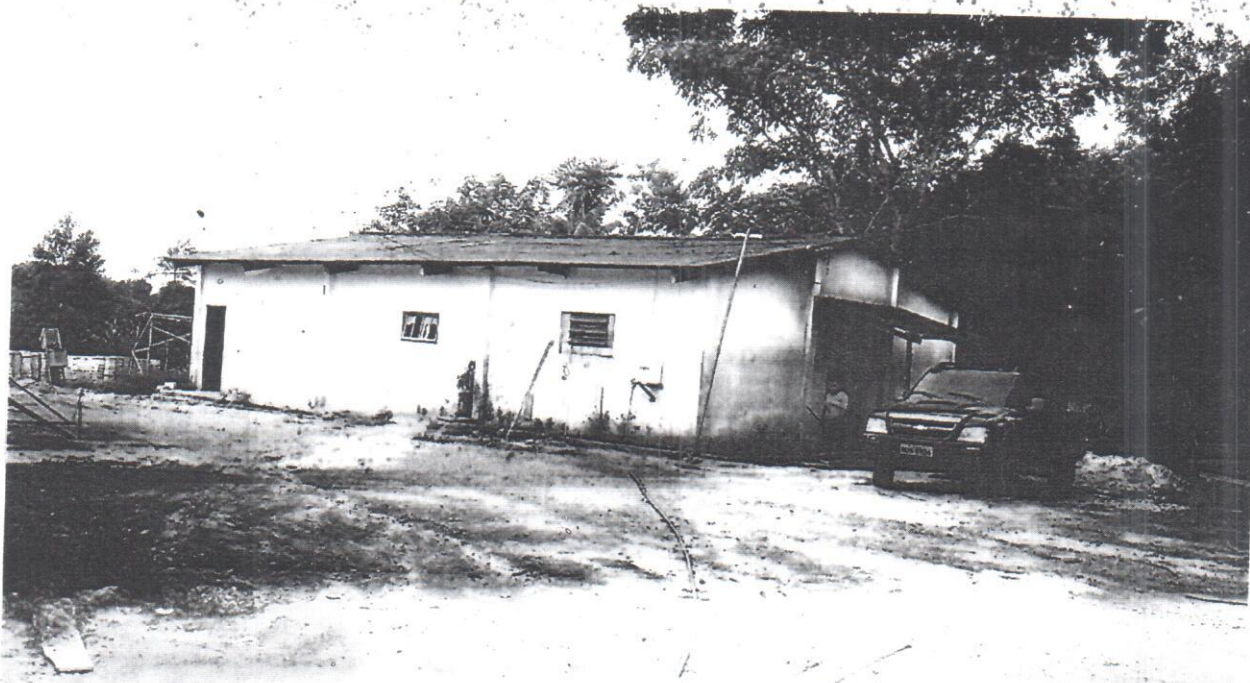
Fotografia 9 – Barracão de Obra.
