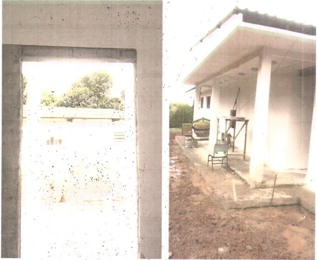
Fotografia14- Elevação do Vão de Porta- Área da Churrasqueira (Execução de verga com tijolos solo-cimento foto à esquerda).
