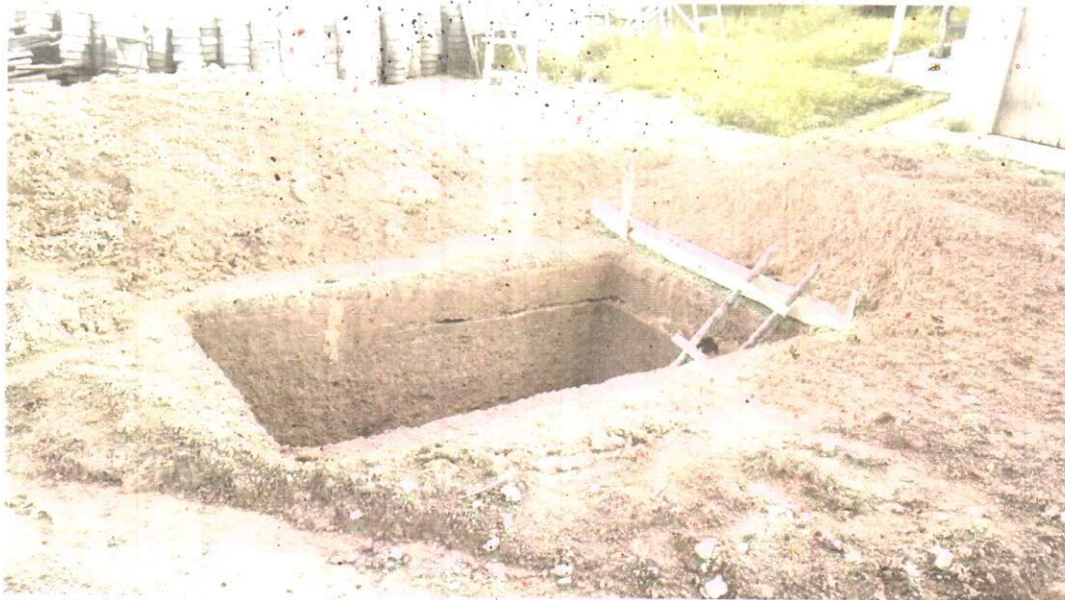
Fotografia 5 – Escavação da Fossa e Caixa Separadora de Gorduras (Instalações Hidrosssanitárias)
