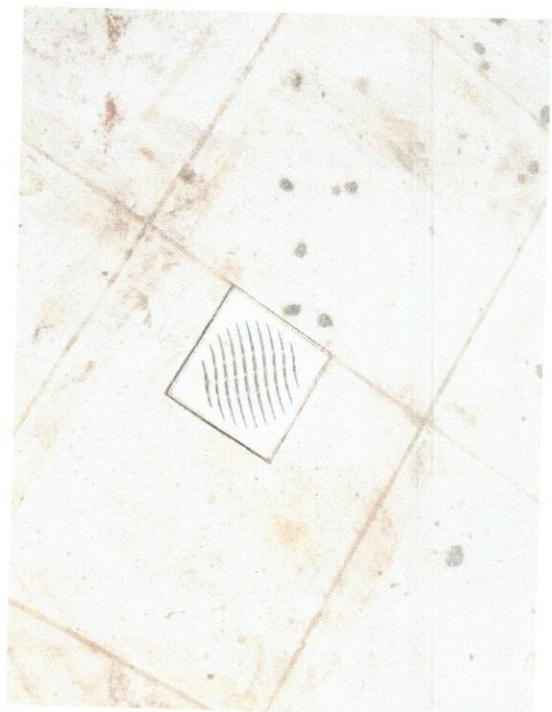
**Foto 2.04** – Piso cerâmico em fase de rejuntamento.
