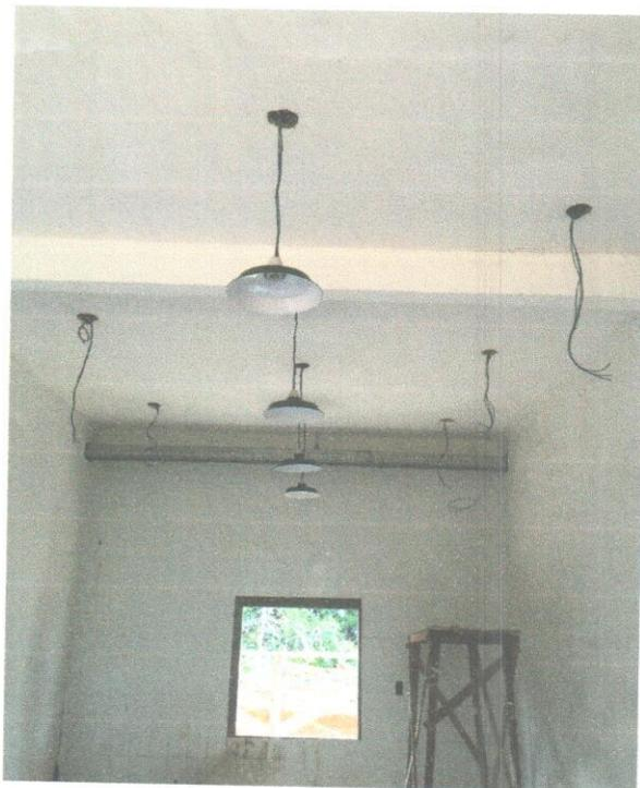
**Foto 5.04** – “Rabichos” dos cabos elétricos para instalação das luminárias.
