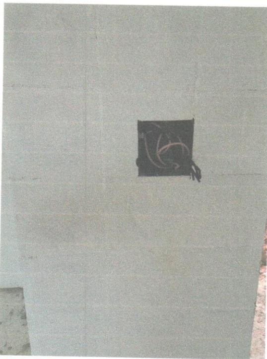
**Foto 5.07** – Caixa 4"x4" com cabos fases e retornos do interruptor de três teclas para comando de iluminação.
