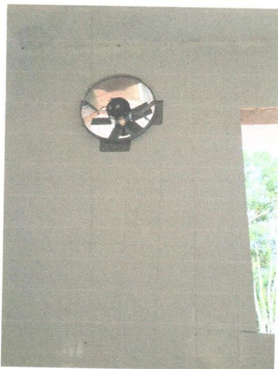
**Foto 5.09** – Exaustor industrial axial monofásico, 40 cm, para desorização dos odores da cozinha.
