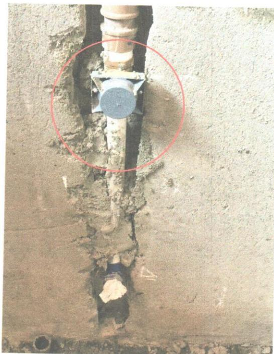
**Foto 9.04** – Válvula de descarga 1./12" com registro, acabamento em metal cromado.
