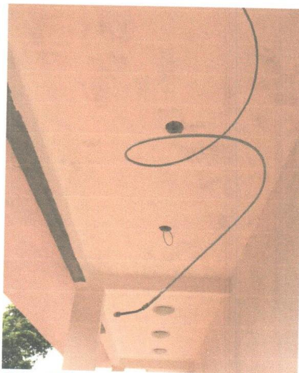
**Foto 5.12** – Arame 12 BWG, utilizado para passagem dos cabos elétricos entre outros nos eletrodutos.
