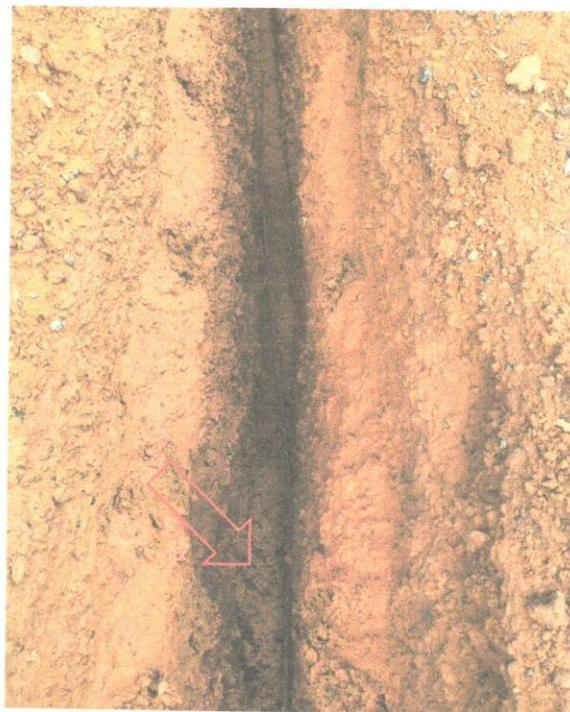
**Foto 5.06** – Cordoalhas de cobre nú assentados na vala do aterramento.
