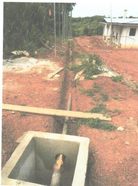
**Foto 9.02** – Vista geral da tubulação de PVC rígido 60 mm para alimentação de água potável.
