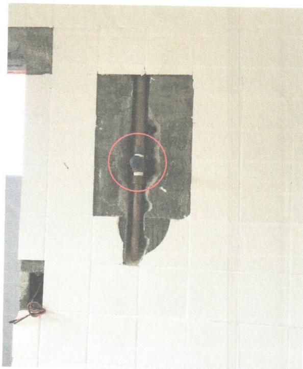
**Foto 9.08** – Registro de gaveta em PVC rígido  $\varnothing$  3/4".
