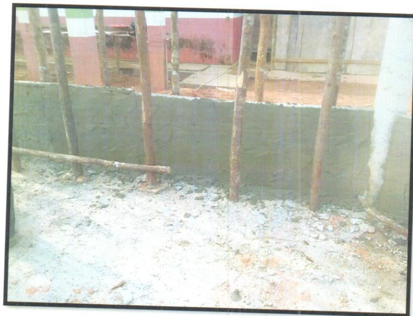
Fotografia 2 – Execução de reboco sem a utilização das mestras de marcação.
