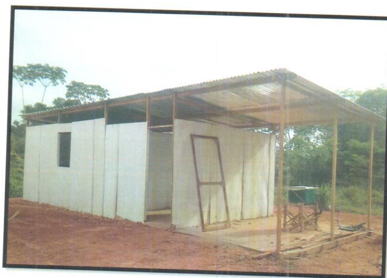
Fotografia 4 – Barracão da obra não concluído.
