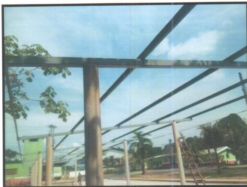
Fotografia 7 – Vista da estrutura metálica da cobertura.
