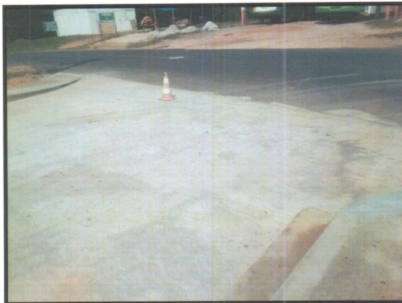
Fotografia 1 – Vista da transição do pavimento rígido para o flexível.
