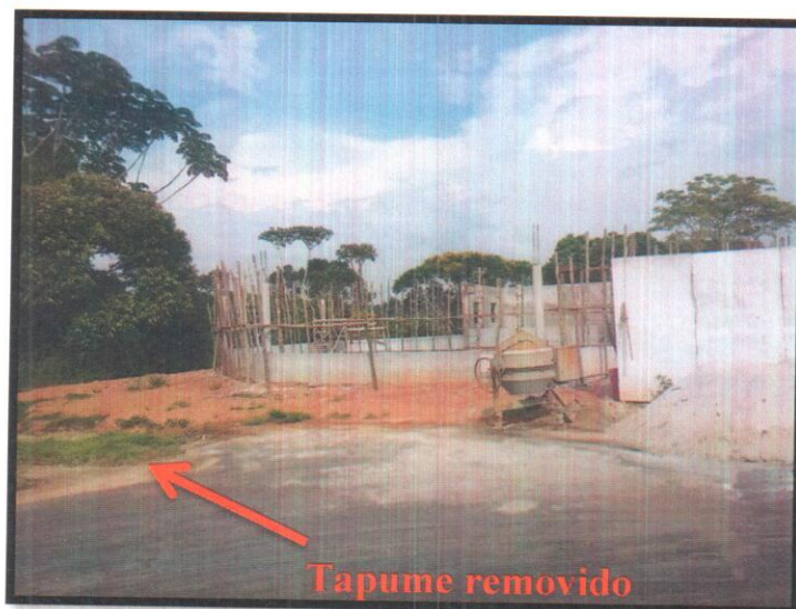
Fotografia 9 – Parte do Tapume Removido.
