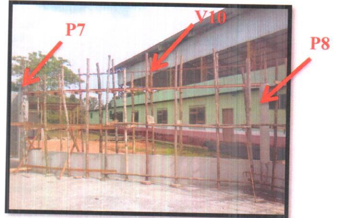
Fotografia 8 – Uniformização dos Pilares para 2,60 e assentamento de Viga com altura de 50 cm.
