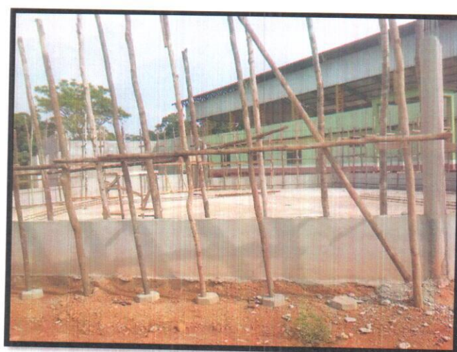
Fotografia 7 – Escoramento para assentamento da Forma da Viga aérea
