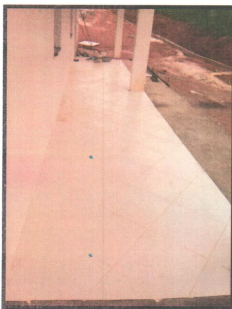
Fotografia 6 – Assentamento revestimento cerâmico no Pátio Frontal
