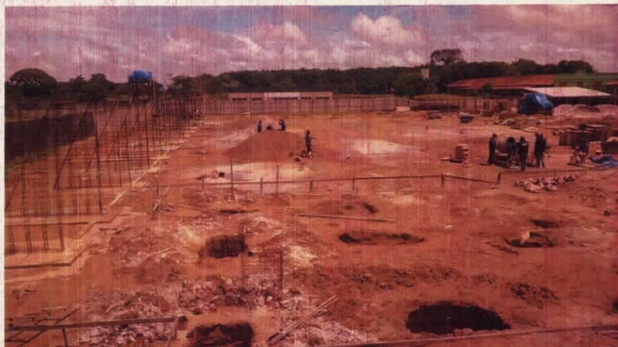
Figura 01: Colocação das armações, no entanto sem montagem das formas ou qualquer tipo de escoramento;
