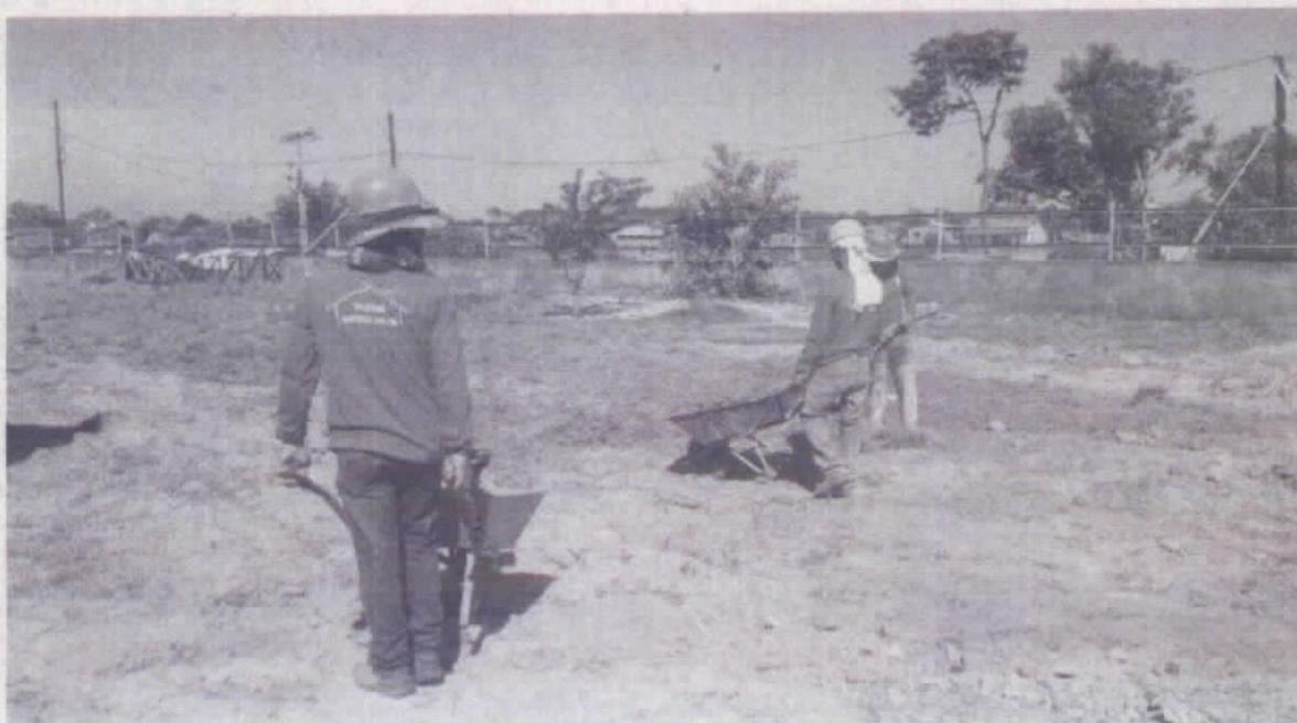
*Figura 1 - Limpeza da área externa da edificação.*
