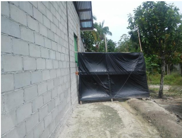
Local onde fica o espaço que utilizam como “banheiro”. Obs: Fechado com uma lona, (lado da casa).
