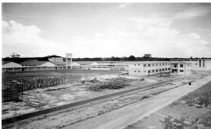
Figura 2: vista área da construção da Escola Técnica Federal de Manaus em 1941, na antiga Praça Rio Branco. Fonte: Dissertação de Mestrado de Ana Cláudia R. de Souza, 2002.
