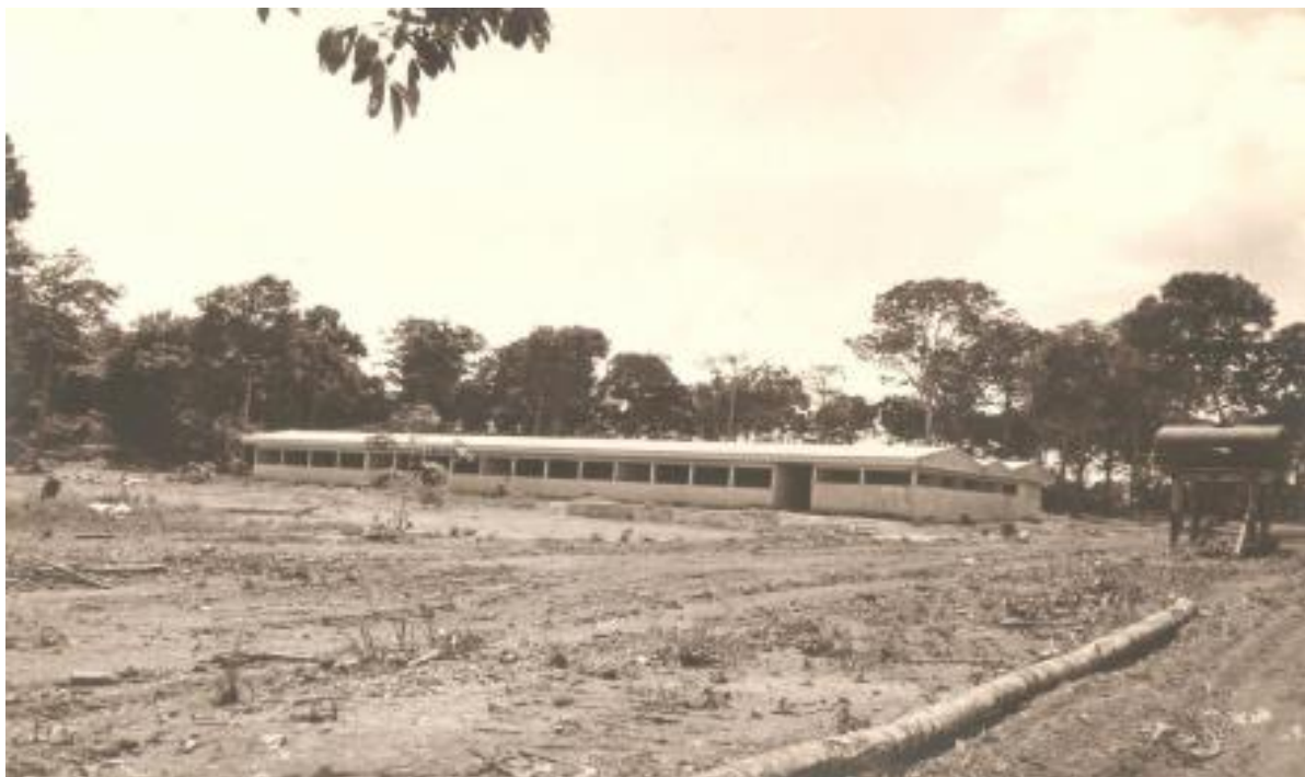
Figura 5 - Construção do Colégio Agrícola, endereço atual – 1970
