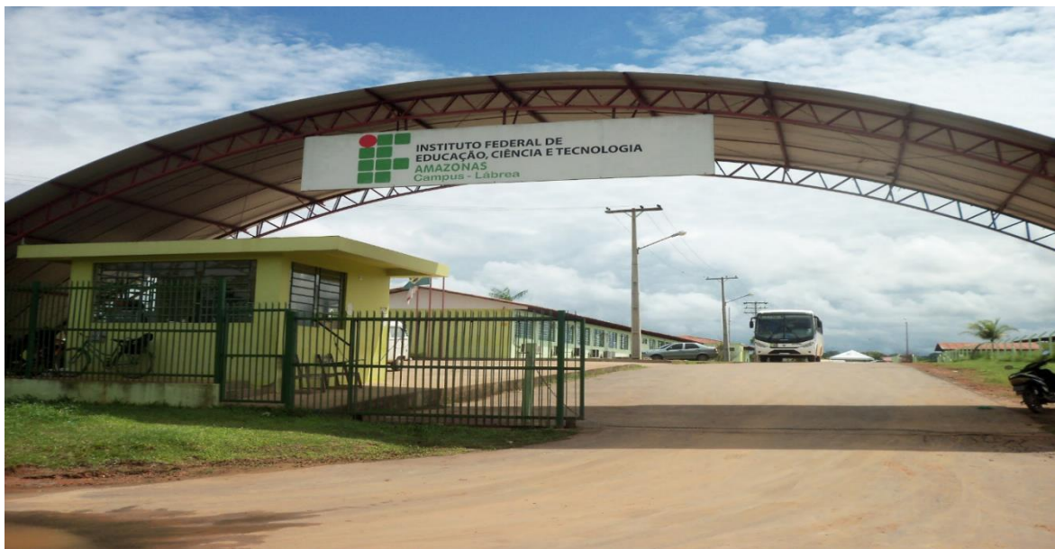
Figura 11 – Vista da entrada do campus Lábrea
