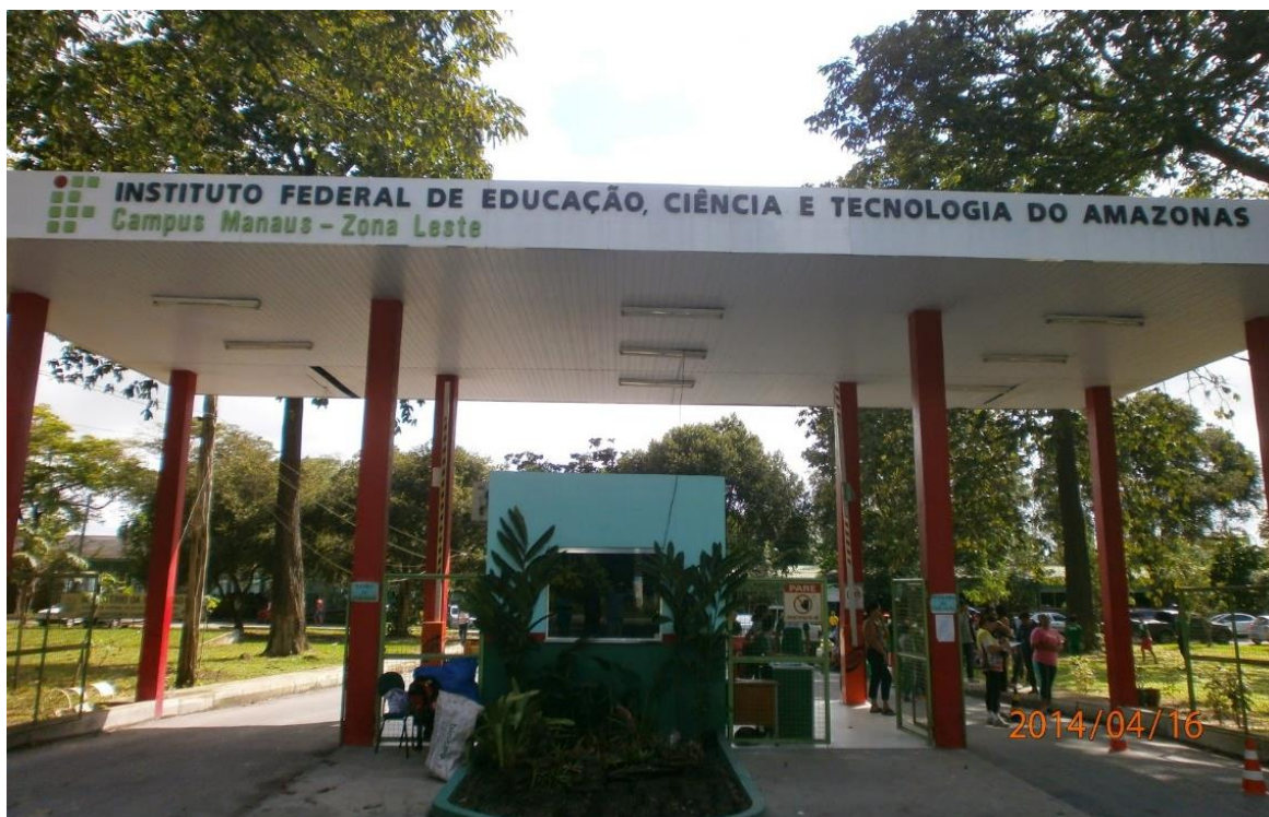
Figura 6 - Vista da Entrada do campus Manaus Zona Leste
