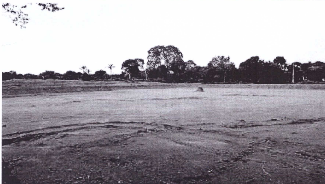
Foto 3. Terreno onde será construída a unidade de ensino de Itacoatiara. Terraplenagem realizada
