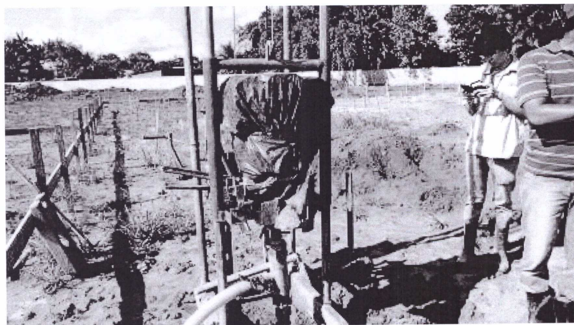
Foto 6. Equipamento de perfuração das estacas raiz na unidade de ensino de Eirunepé.
