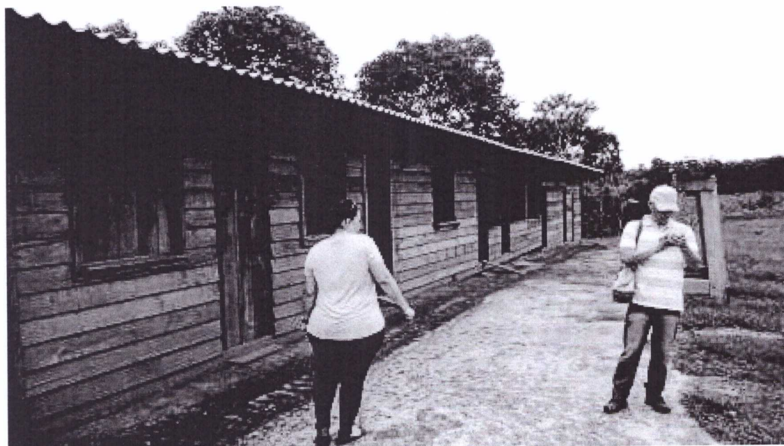
Foto 2. Barracão de obras da unidade de ensino de Tefé.
