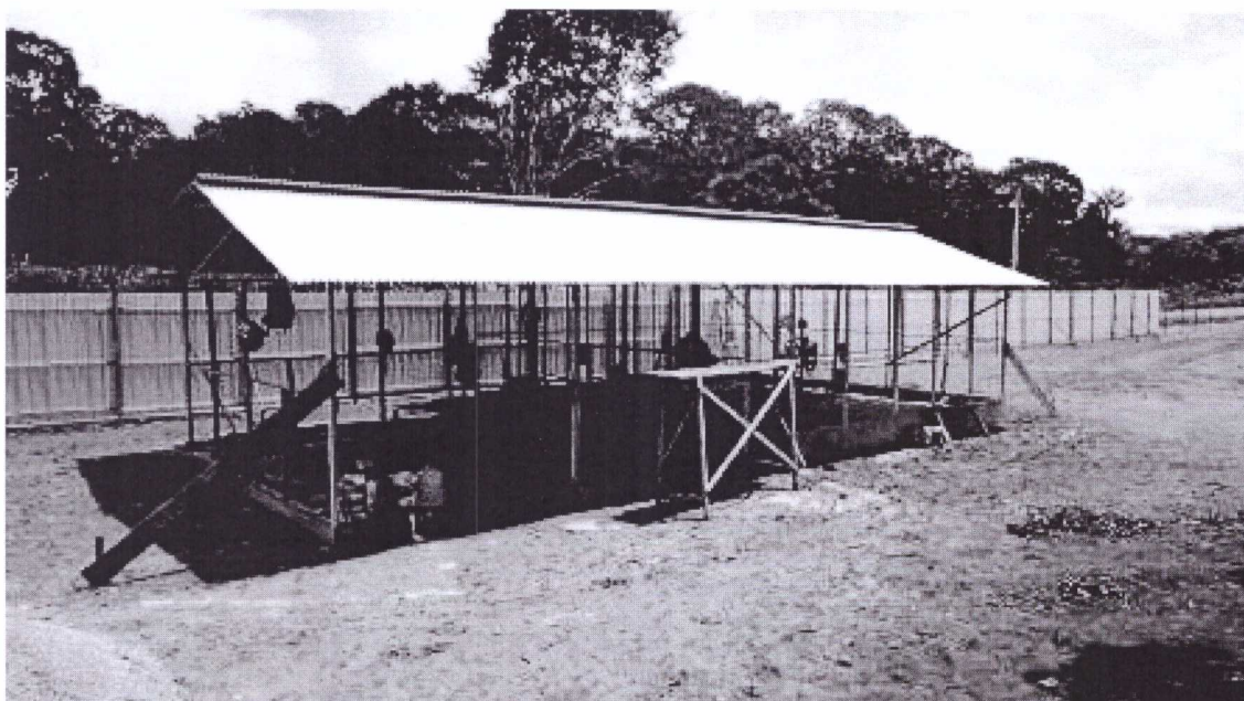
Foto 4. Barracão de obras da unidade de ensino de Itacoatiara em construção.
