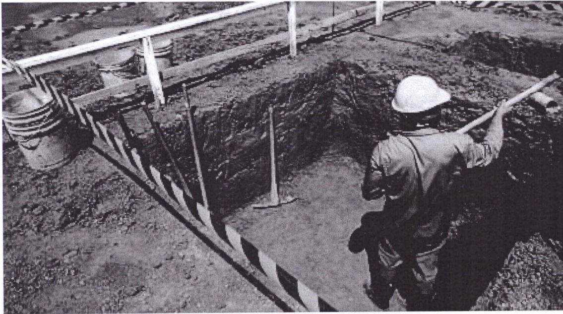
Foto 7. Escavação para construção de uma sapata na unidade de ensino de Humaitá.
