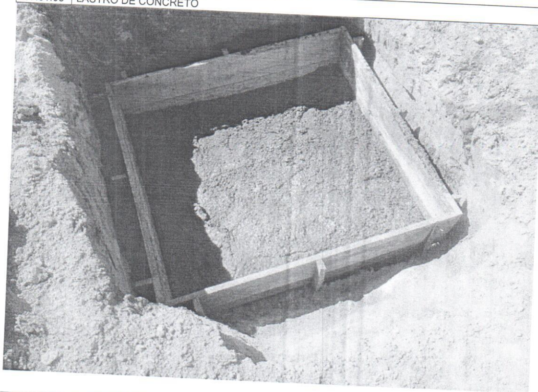
07.01.04 FORMA DE MADEIRA COMUM PARA FUNDACOES - REAPROVEITAMENTO 5X
