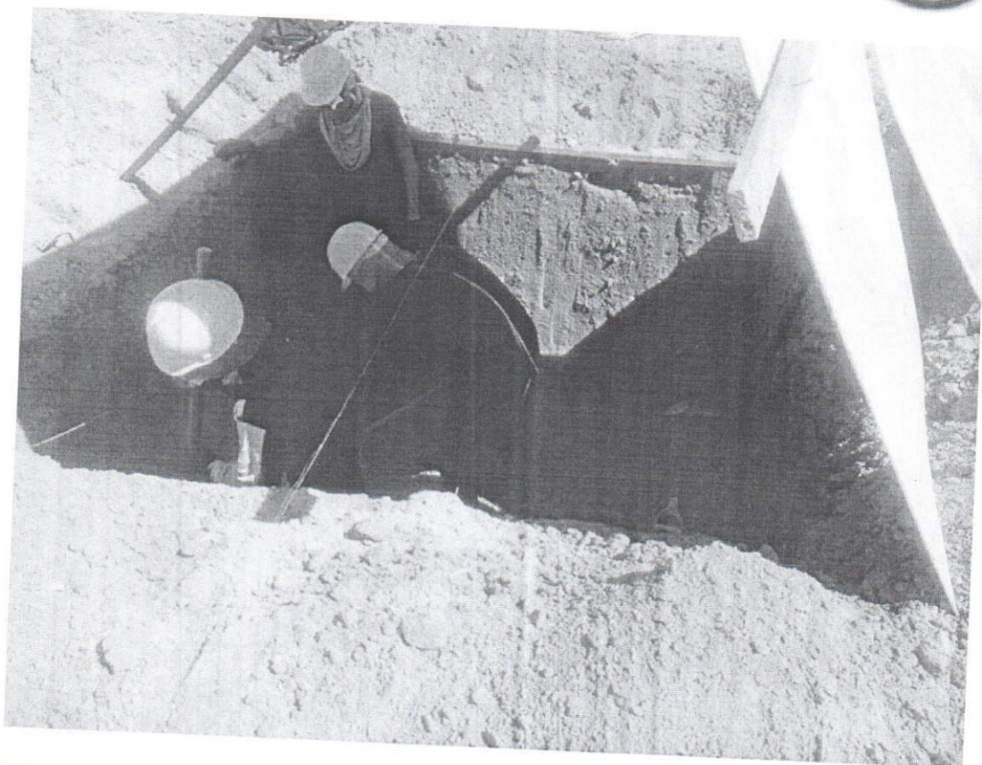
07.01.03 LASTRO DE CONCRETO
