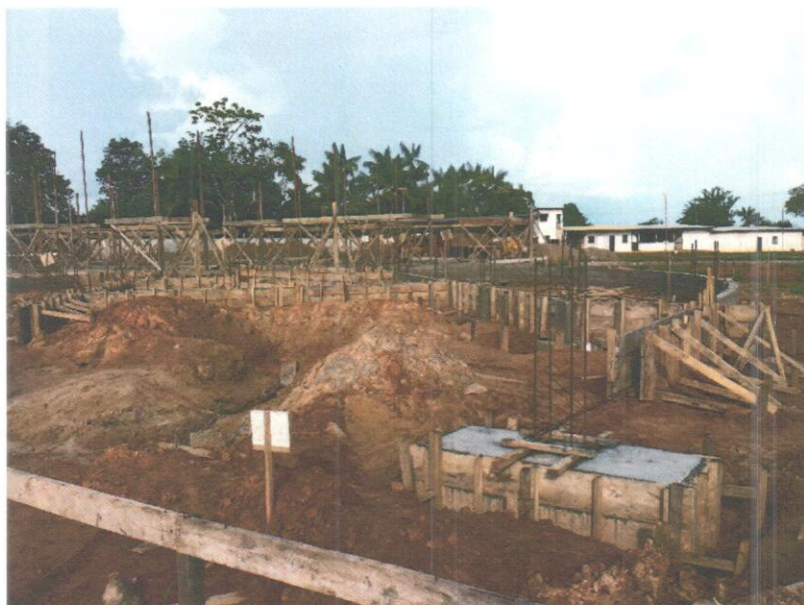
Fotografia 9 – Vista aproximada do trecho central da edificação, com execução de serviços de escavação e concretagem recém realizadas.
