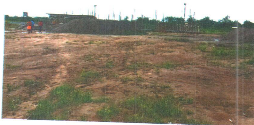
Fotografia 2 – Vista da face leste da edificação. Detalhe para a presença de agregados graúdos no canteiro de obras.
