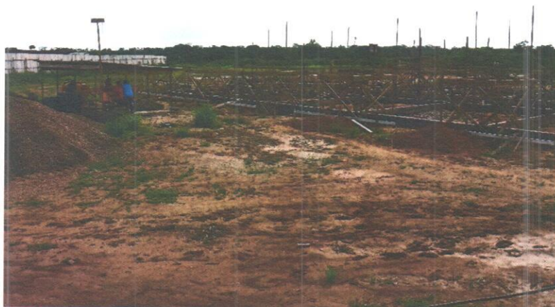
Fotografia 4 – Vista da asa leste da edificação.
