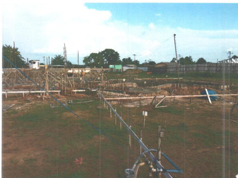
Fotografia 8 – Vista posterior da área central da edificação com as vigas baldrame em face de conclusão.
