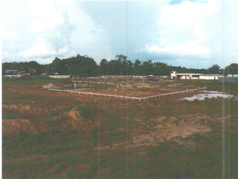
Fotografia 13 – Vista em ampla da lateral leste da edificação, mostrando o atual estágio da obra.
