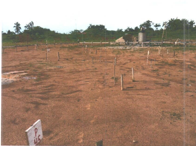
Fotografia 11 – Vista interna da asa oeste da edificação apenas com a locação de pilares.
