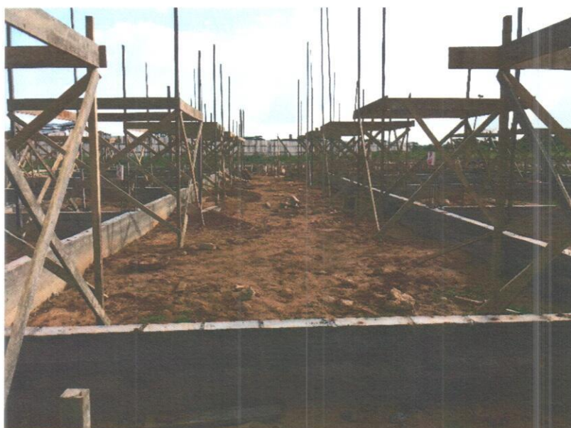
Fotografia 6 – Vista do corredor central (térreo) da asa leste da edificação.
