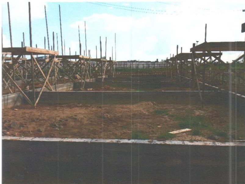
Fotografia 7 – Vista das vigas baldrame da asa leste da edificação. Detalhe para as fôrmas dos pilares em execução e para as vigas já desformadas.
