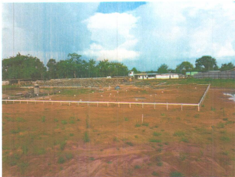
Fotografia 1 – Vista da lateral oeste da edificação, em 26 de setembro de 2014, metade da edificação ainda não foi construída.
