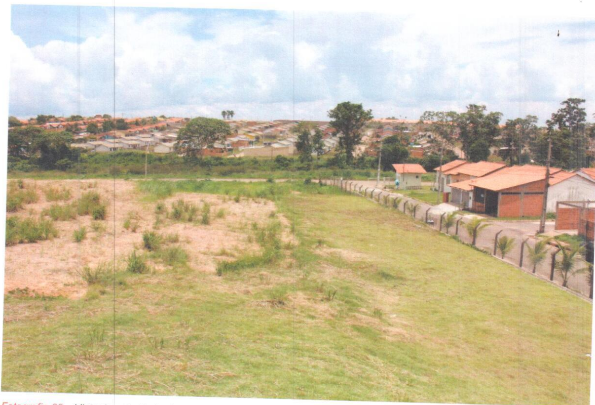
Fotografia-22 – Vista do setor leste do campus. Destaque para o revestimento vegetal do talude.
