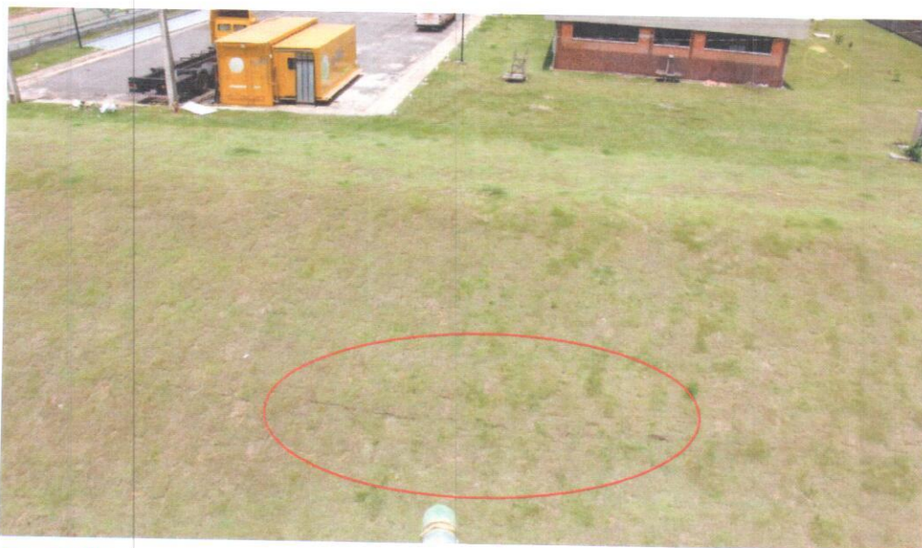
Fotografia-03 – Vista do talude entre o estacionamento frontal e o Bloco A. No destaque ravinhas em formação eventualmente devidas à ação das chuvas e das intempéries, ou até mesmo devido à compactação inadequada da proteção natural do talude.
