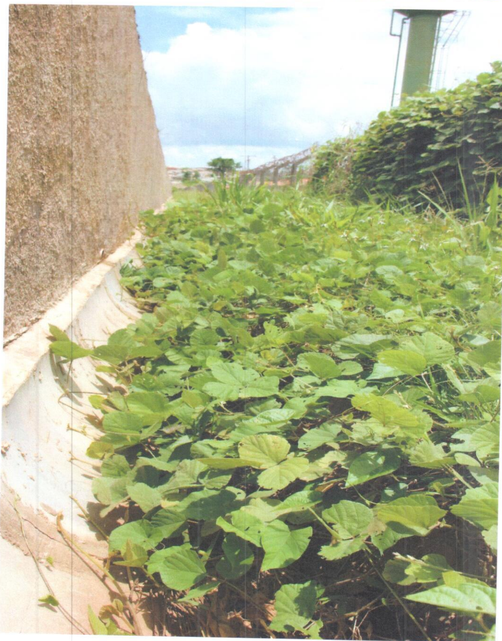
Fotografia-20 – Vista do paramento externo do muro de arrimo no trecho entre o muro frontal e o reservatório do condomínio. Nota-se a obstrução da canaleta completamente devido o avanço da vegetação rasteira.
