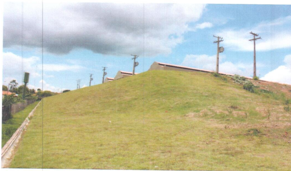
Fotografia-11 – Vista da saia do talude do setor leste do campus. Nota-se visualmente a ausência da movimentação do maciço neste local, tendo em vista a verticalidade dos postes da rede elétrica interna.
