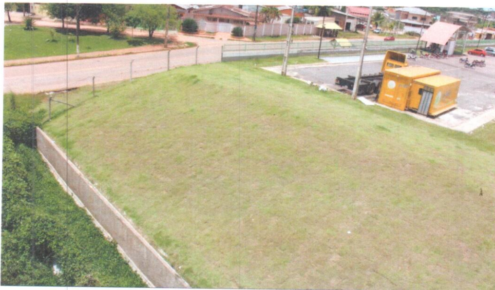
Fotografia-02 – Vista da ala oeste do talude. Ao fundo, cerca alambrada do muro frontal, abaixo paramento externo do muro de arrimo.
