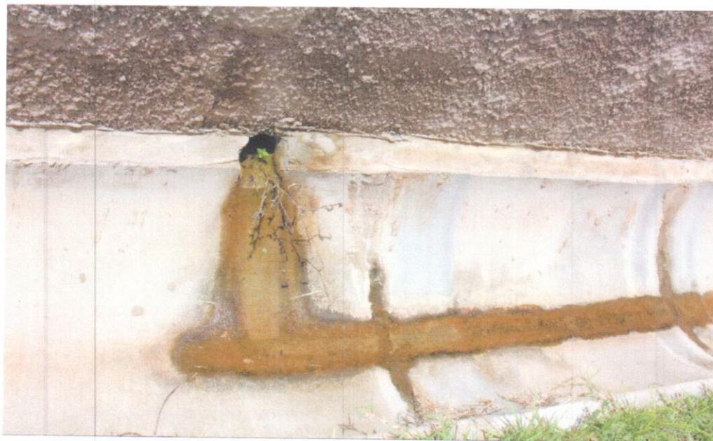
Fotografia-18 – Vista entre o pé do muro de arrimo e a canaleta. Neste trecho nota-se o funcionamento da drenagem e a canaleta desobstruída.
