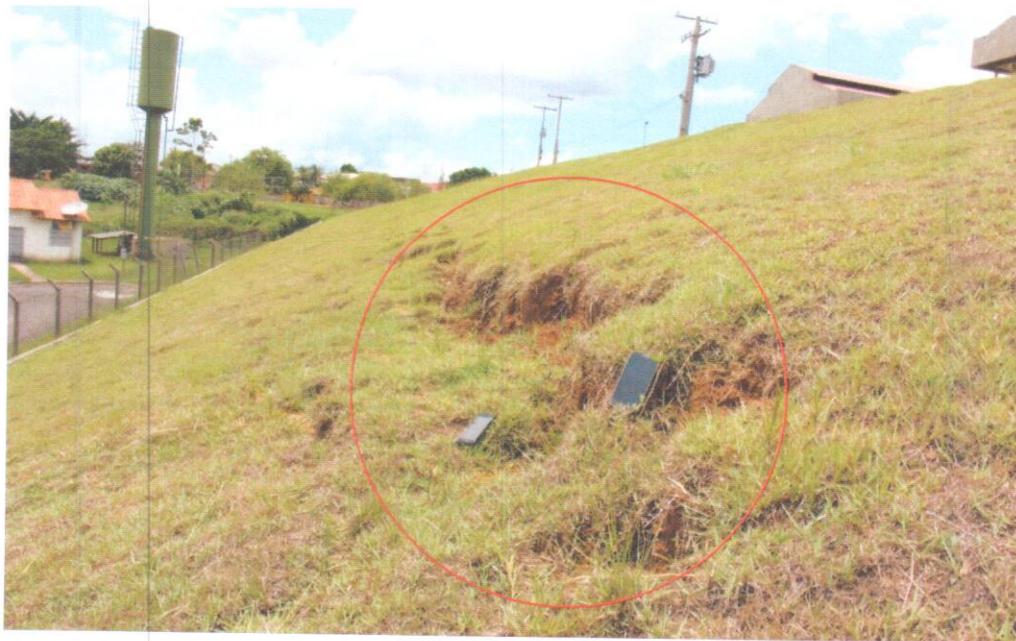
Fotografia-07 – Comparação dos sucus das ravinas com aparelhos de telefone móvel (7x13,5) cm. Nesta área afetada é imprescindível a recomposição do solo e o plantio imediato de gramas de rápido crescimento.
