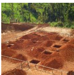
Vista da movimentação de terra do ginásio
