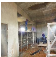
Parte interna da Obra, aplicação de chapisco.
