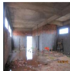
Vista interna da biblioteca
