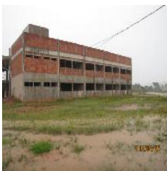
Vista da lateral direita do bloco A
