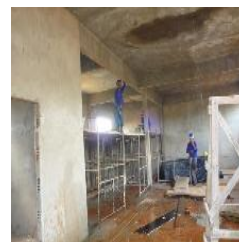
Corredor do blocos A
