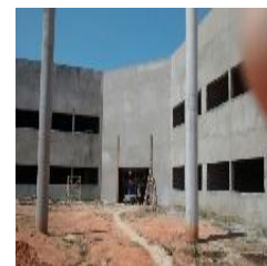
Vista posterior do prédio
