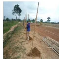
Fases da execução do tapume no setor sul do terreno paralelo a Rua Projetada: escavação das valas, assentamento e compactação da base dos mourões.
