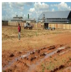
Vista interna do canteiro de obras, a partir do setor oeste do terreno. Ao fundo destaque para o equipamento de escavação do poço tubular seguido do Centro Sócio Educativo do Purus.
