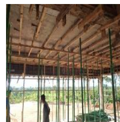
Vista interna do bloco A
