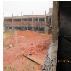
Vista piscina escavada do Campus Sena Madureira
