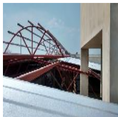
Vista superior da cobertura zenital do prédio do campus.
