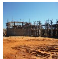
Vista externa do bloco A
