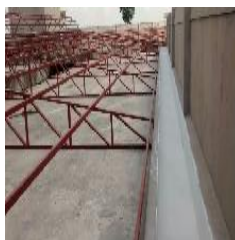
Vista da cobertura da edificação
