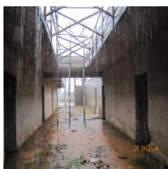
Vista interna da asa esquerda do bloco A
