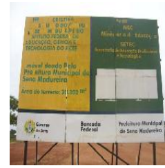
Vista da placa de obra seguindo padrao federal
