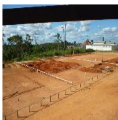
Vista da movimentação de terra do ginásio
