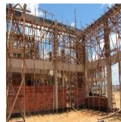
Vista circulação oeste do pavimento térreo do Bloco A. Vista geral do auditório, nota-se a impermeabilização das vigas baldrames e o início da execução da alvenaria.
