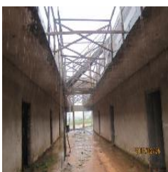
Vista interna da asa esquerda do bloco A
