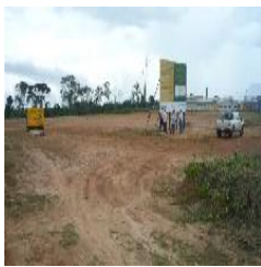
Vista geral do platô para a implantação da obra. À esquerda o grupo gerador, no centro a Placa de Doação do Terreno, ao fundo o Centro Sócio Educativo do Purus.
