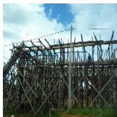
Estrutura da guarita
