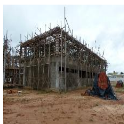
Vista do bloco A, ala leste
