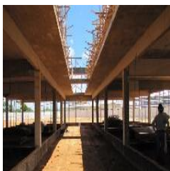
Vista circulação leste do pavimento térreo do Bloco A. Destaque para as salas dos laboratórios de apoio ao ensino.
