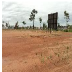
Visão geral do terreno com serviços de terraplanagem concluídos.
