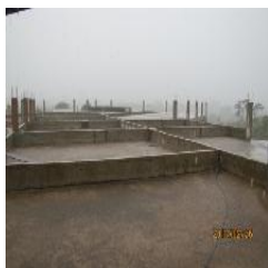
Vista da laje da ala esquerda do bloco A
