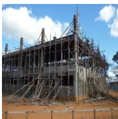
Vista externa do bloco A
