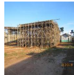
Vista do bloco da agroindústria
