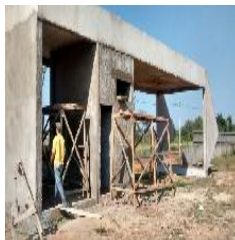
Vista da guarita
