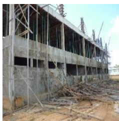
Vista externa do bloco A
