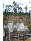
Vista de execução de piscina
