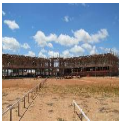
Vista da fachada norte do Bloco A. À esquerda pavilhão dos laboratórios e salas de aula, à direita área administrativa e laboratórios de informática.
