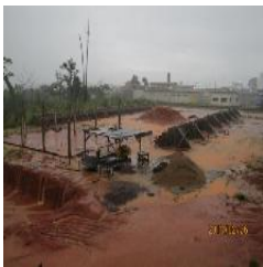
Vista da quadra poliesportiva e estrutura do vestiário
