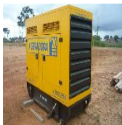
Vista do Grupo Gerador para o fornecimento básico de energia de BT para atender os serviços preliminares da obra.
