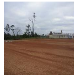
Vista da terraplanagem da area onde sera executada a obra.
