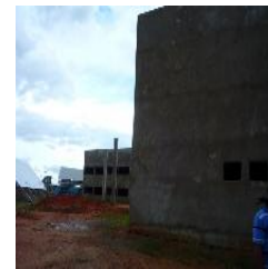
Vista lateral da Obra do Campus
