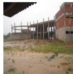
Vista da entrada principal do bloco A
