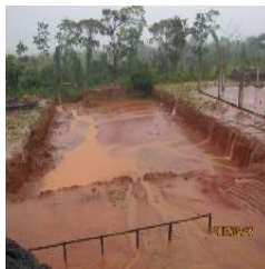
Vista piscina escavada do Campus Sena Madureira
