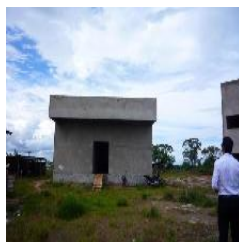
Biblioteca - fase chapisco, embuço e reboco.
