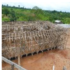
Vista do bloco da Agroindústria
