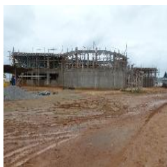
Vista do auditório do Campus Sena Madureira
