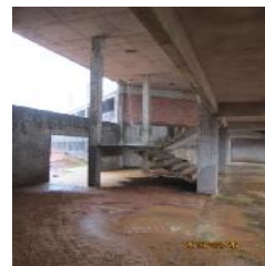
Vista interna da escada do hall central do bloco A
