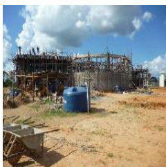
Vista externa do bloco A
