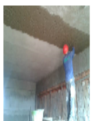
Aplicação do reboco e ajuste no emboço
