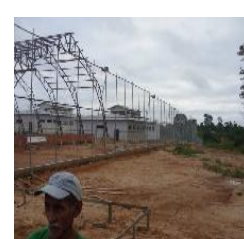
Vista das vias de acesso ao local
