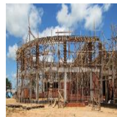
Vista da fachada sul do Bloco A. Destaque para a estrutura e o início da execução da alvenaria do auditório.
