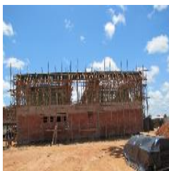
Vista da fachada oeste do Bloco A. À esquerda ala que abriga a área administrativa, e laboratórios de informática, à direita ala que abriga área de ensino e biblioteca.
