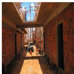
Vista circulação oeste do pavimento térreo do Bloco A. À esquerda departamento pedagógico, administrativo e secretaria escolar, à direita sala de reunião e recepção do diretor.
