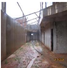
Vista interna da ala esquerda do bloco A
