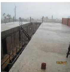
Vista da laje da ala direita do bloco A
