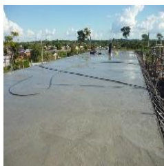
Vista da cobertura do bloco A
