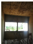
Aplicação do reboco e ajuste no emboço
