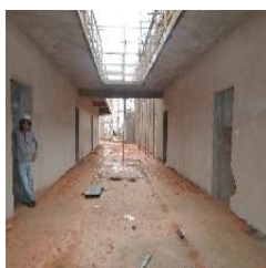
Vista do Pavimento térreo, ala oeste
